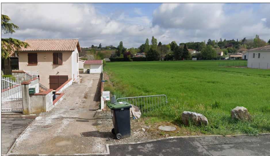
Vue sur le fossé d'écoulement des eaux pluviales depuis la route de Bazus
